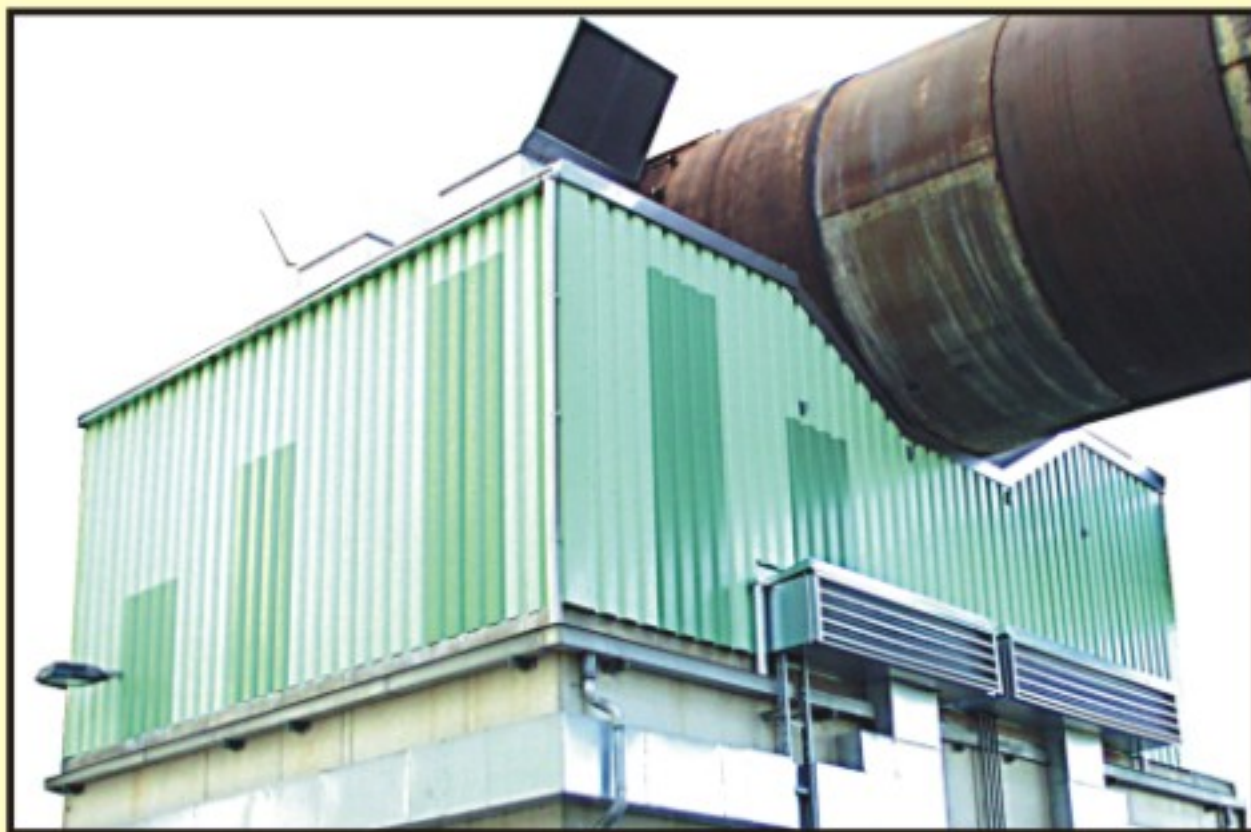
Schallschutzkabine mit Zu- und Abluftschalldämpfer für den schallemissionsgerechten Betrieb eines Drehofens. Aussenverkleidung aus Trapezblech in RAL Ton nach Wahl des Kunden. Innenverkleidung aus Edelstahl 1.4301.
