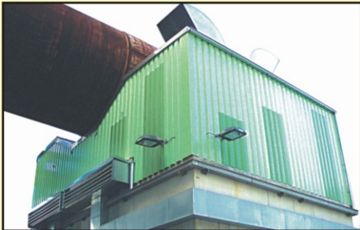
Schallschutzkabine mit Zu- und Abluftschalldämpfer für den schallemissionsgerechten Betrieb eines Drehofens. Aussenverkleidung aus Trapezblech in RAL Ton nach Wahl des Kunden. Innenverkleidung aus Edelstahl 1.4301.
